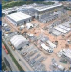
Unidade de Fabricação de Estruturas Metálicas (UFEM)
